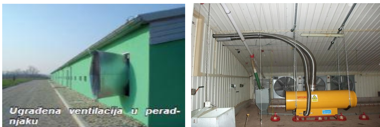
Slika 20.: Sustav za provjetravanje u peradarniku
